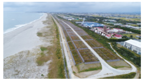
防潮堤の整備状況
