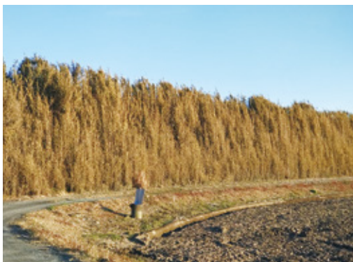
三沢川堤防の雑木伐採
