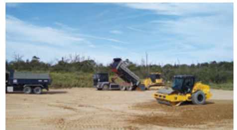
盛り土造成工事
