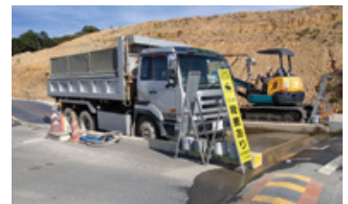
発生土搬出前に受水槽で車輪を洗う
