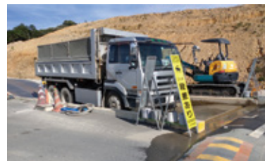
発生土搬出前に受水槽で車輪を洗う
