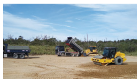
盛り土造成工事
