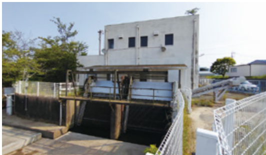
柳原排水機場
