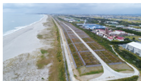
防潮堤の整備状況
